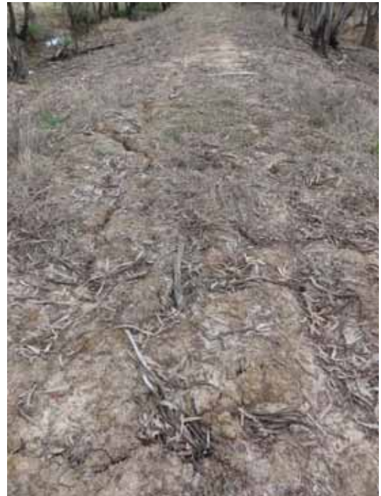
Erosion : cracks
